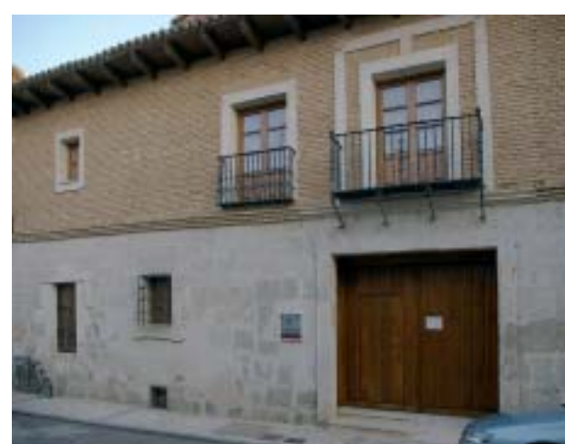
Una casa señorial del siglo XVII acoge el centro de visitantes, respetando su estructura original y parte de los elementos característicos de las casas solariegas de la comarca.
